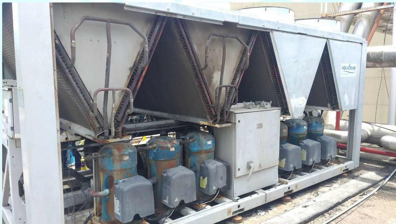
Imagem 2 – Segundo equipamento chiller a ser removido
