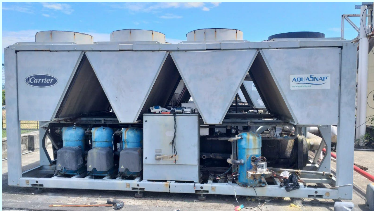
Imagem 1 – Primeiro equipamento chiller a ser removido
