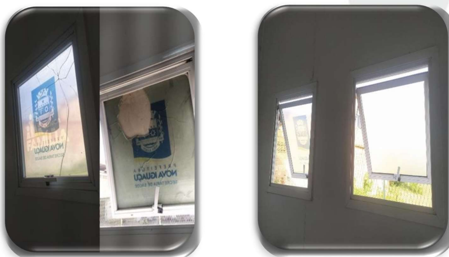
Substituição de janelas danificadas – Clínica da Família Jardim Palmares
