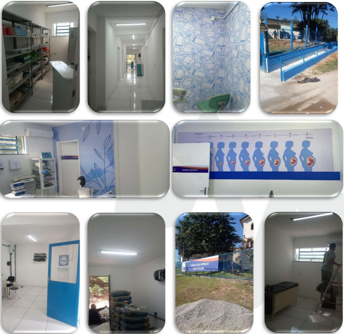
Reforma em andamento – Clínica da Família Rio D'Ouro
