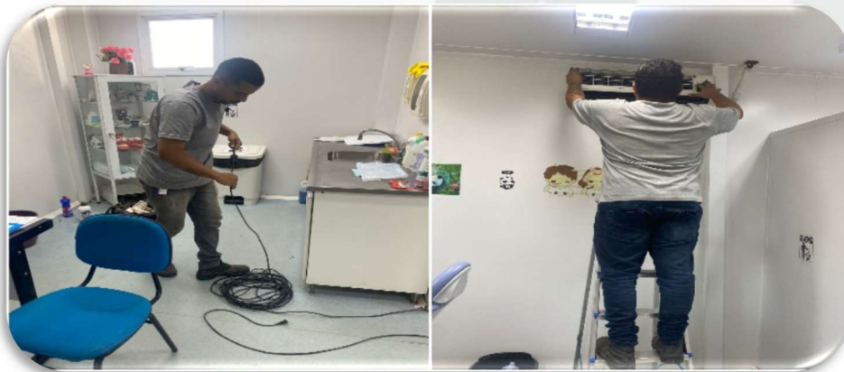
*reparo ar condicionado C. F. Emília Gomes
