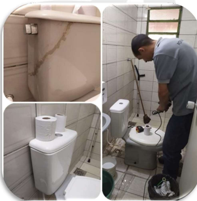
*reparo no banheiro C. F. Parque das Palmeiras
