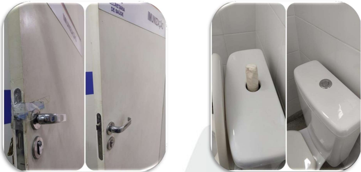
*reparos realizados na C.F. Santa Clara do Guandu
