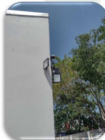
instalação de refletor C. F. Valverde
