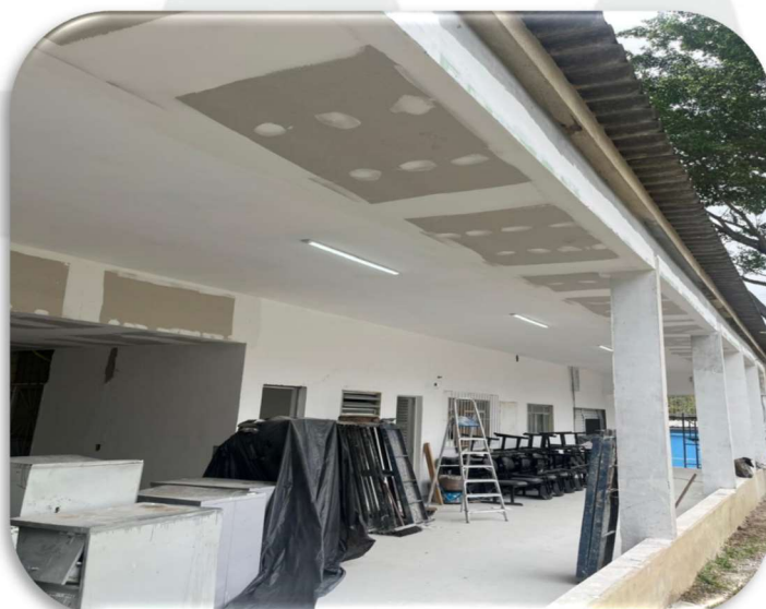
antes x durante reforma área externa
